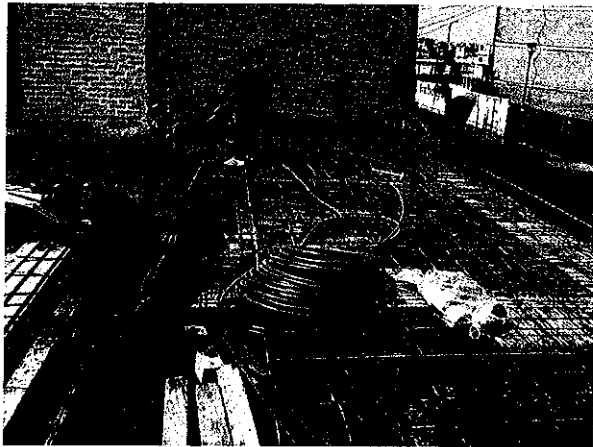
Foto 9.- Cimbrado para la losa del 2do. Nivel.
