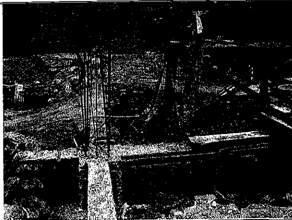
Foto 11.- Armado de Trabes.
